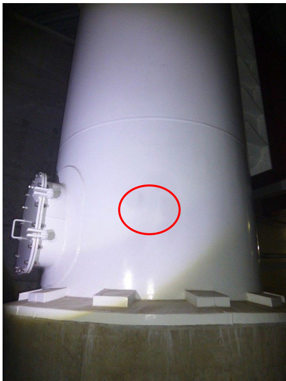
図3 排気筒のケレン塗装箇所（視点1）
