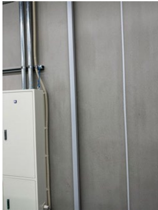
1.レギュレーター設置予定箇所
