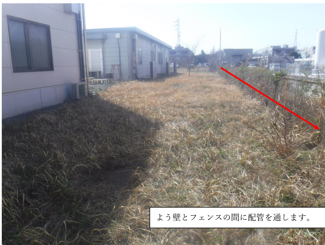
よう壁の上 電源棟へのラダーの西側
