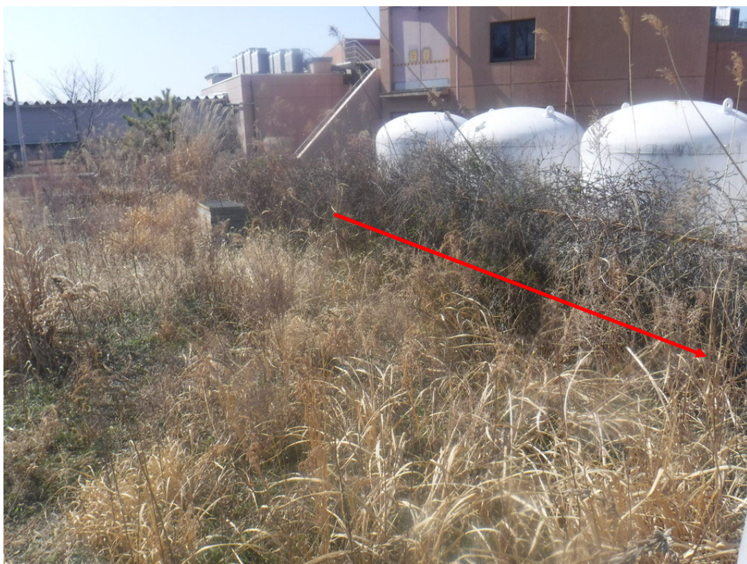
よう壁の上 ヘリウムバッファタンク付近
