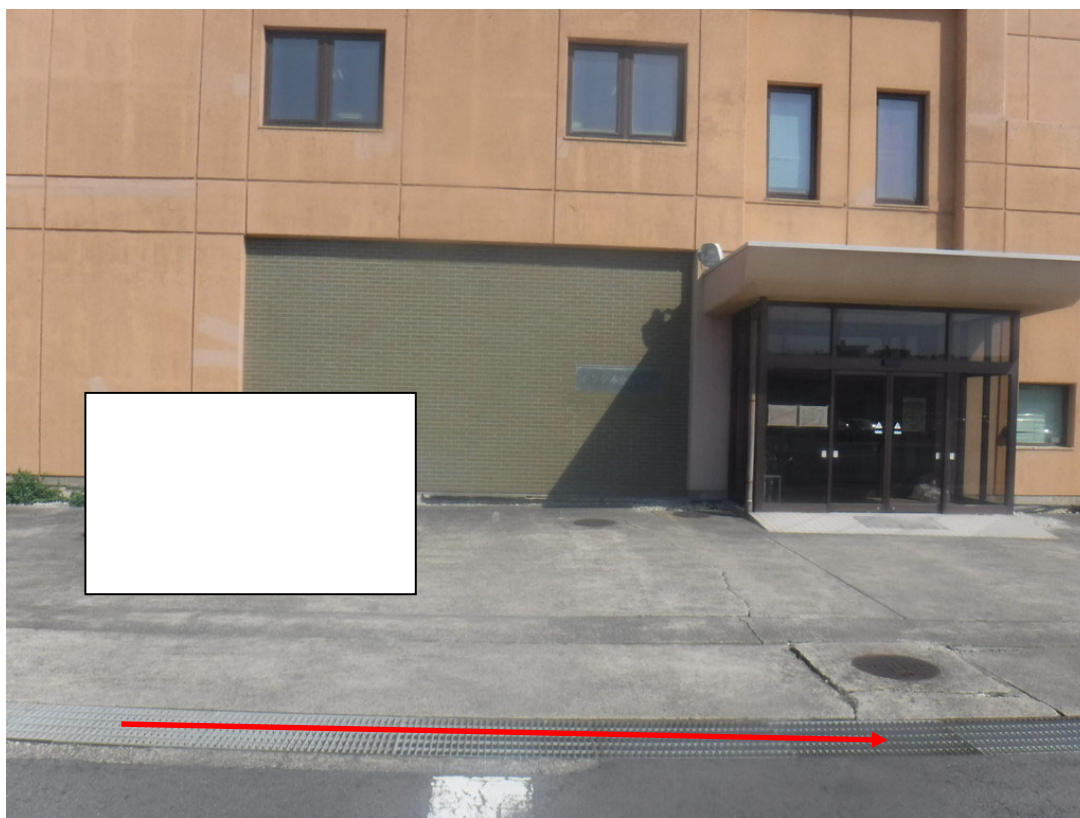
タンデム棟 玄関の北側 2
