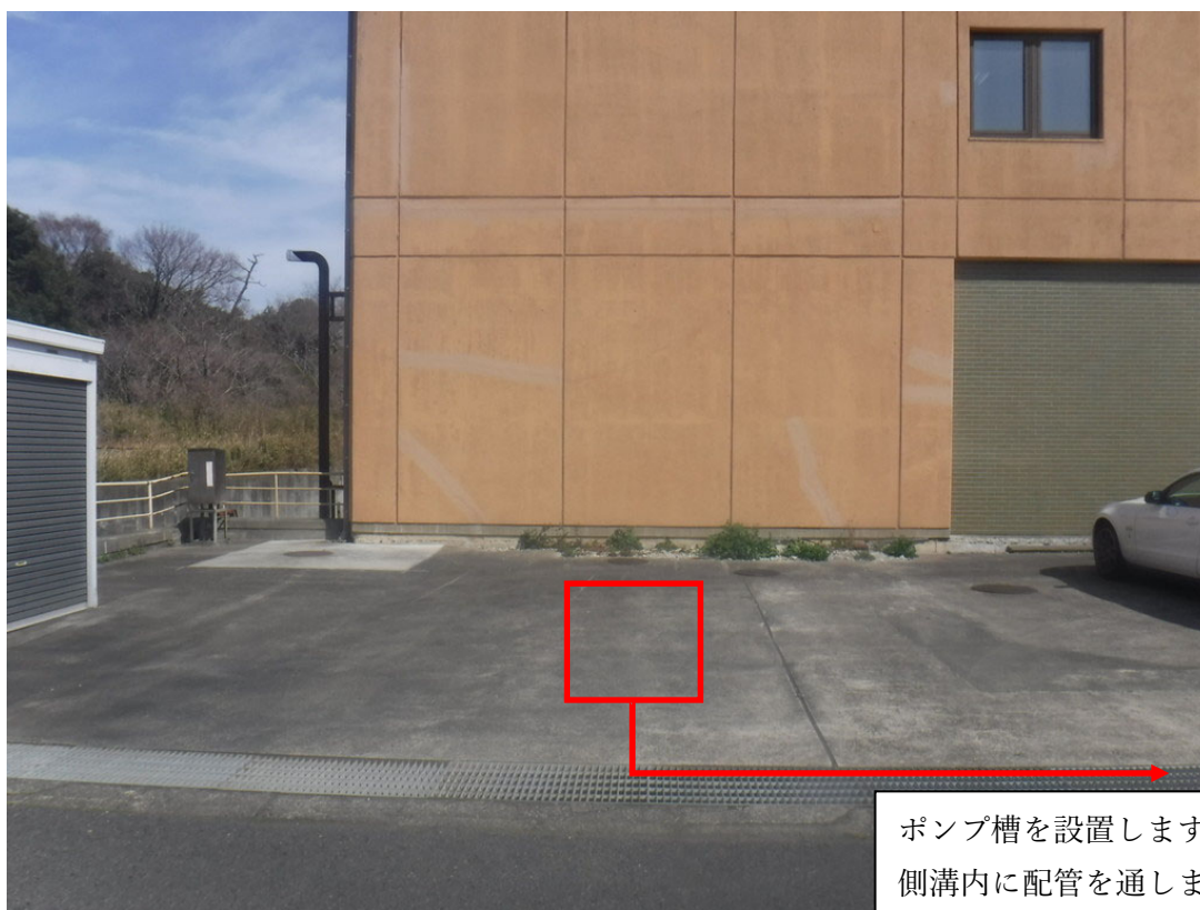
タンデム棟 玄関の北側 1
