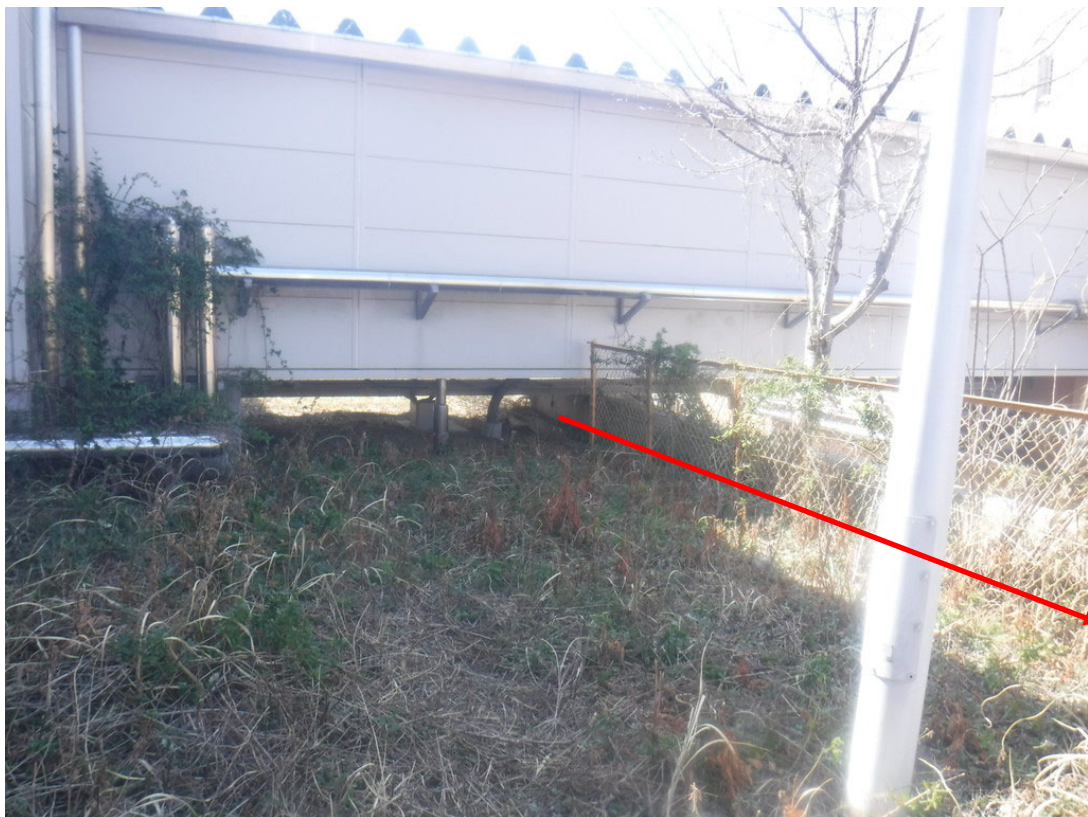
よう壁の上 電源棟へのラダーの東側
