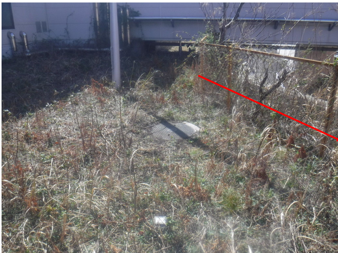
よう壁の上 電源棟の東側
