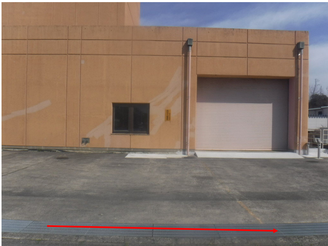
タンデム棟 玄関の南側 2
