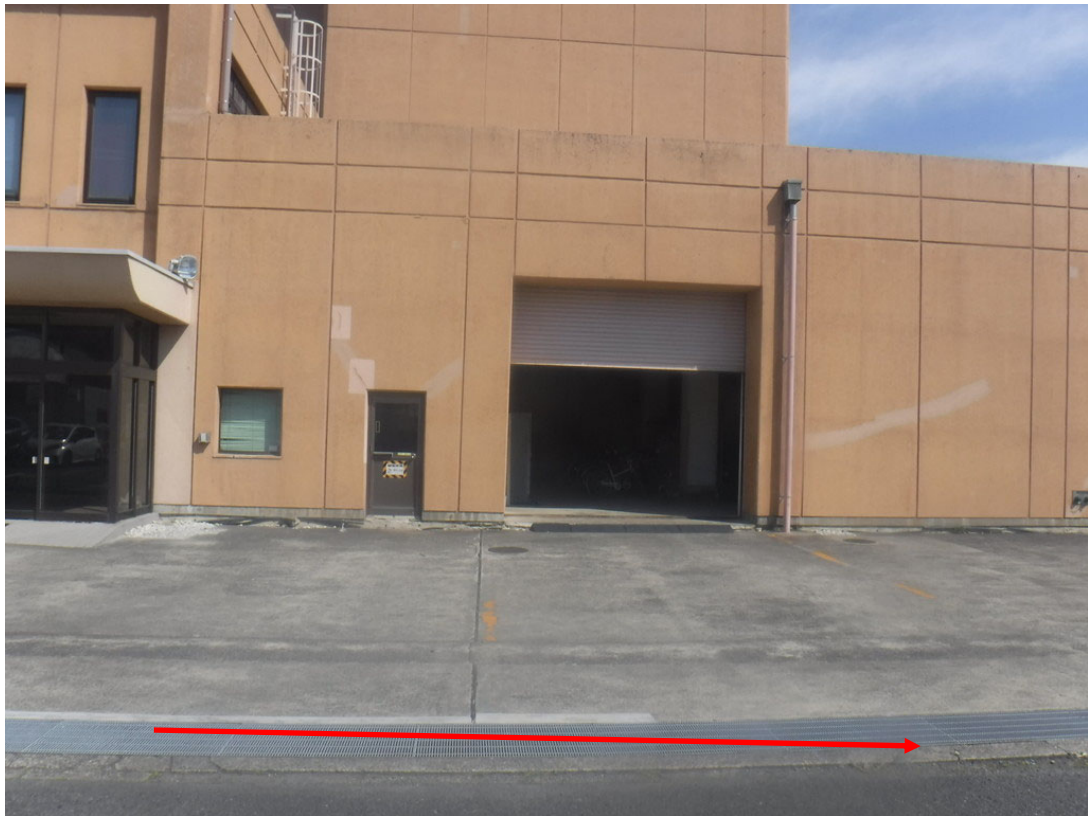
タンデム棟 玄関の南側 1
