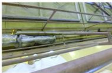
図5 撤去・搬出する対象物品（112室）
