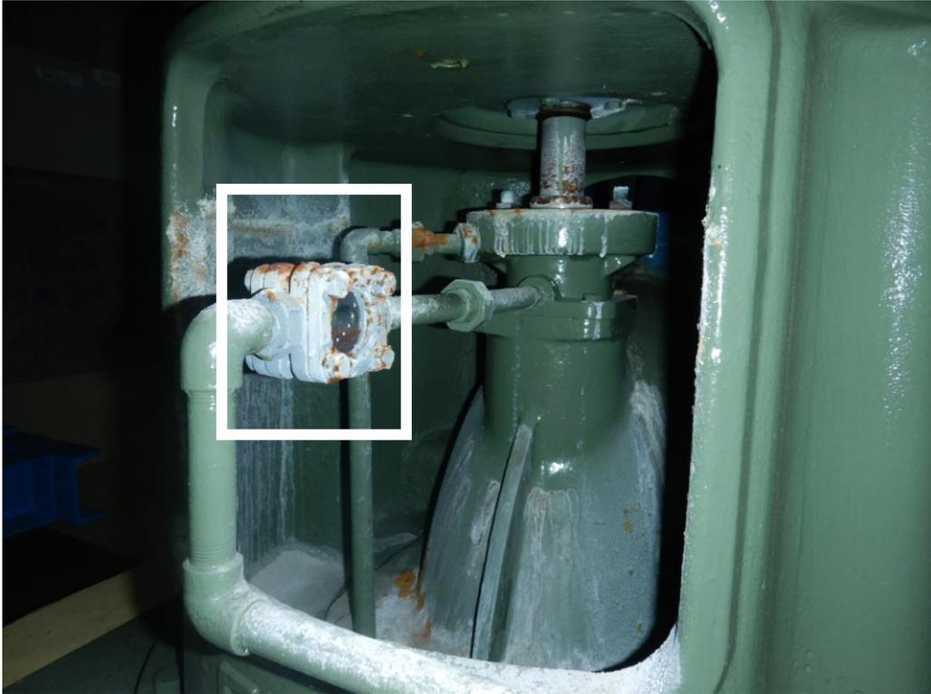
写真2 補機系揚水ポンプドレン配管
