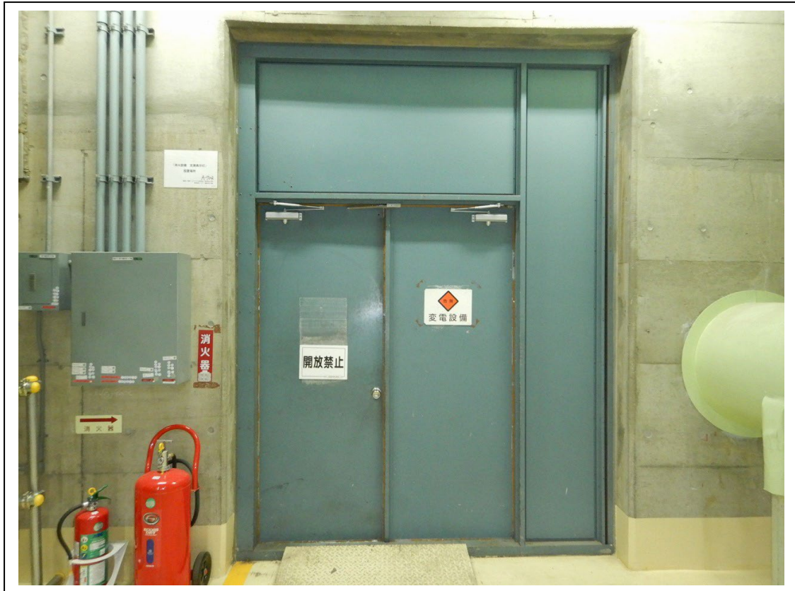
添付写真1 A-705 室 ⇄ A-706 室の境界扉
