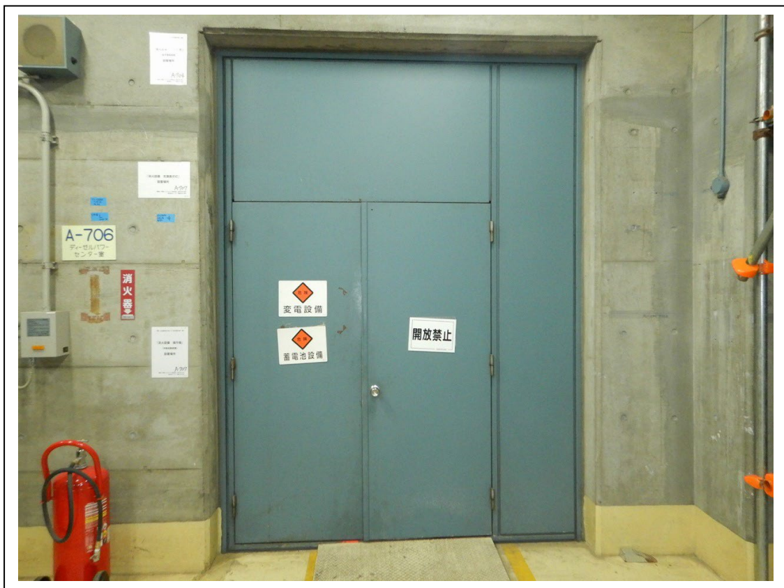
添付写真2 A-706 室 ⇄ A-707 室の境界扉
