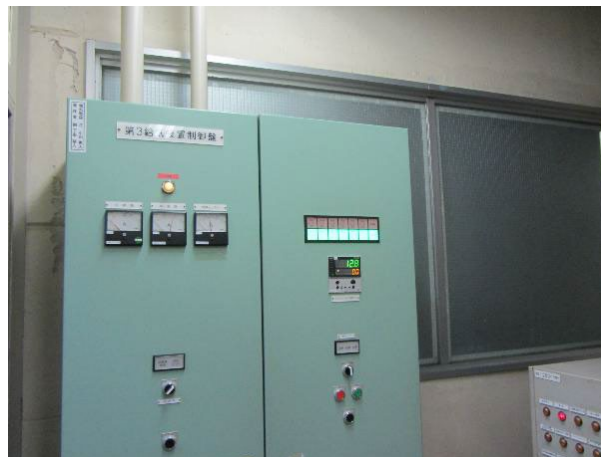
第3 給気装置制御盤
