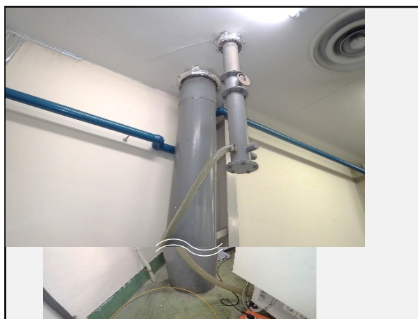
排気ダクト縦管φ約300mm/φ約100mm
