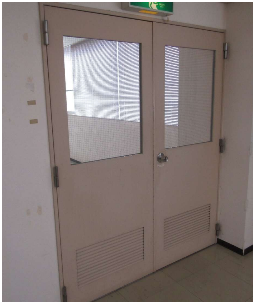
図1 更新対象の居室扉
