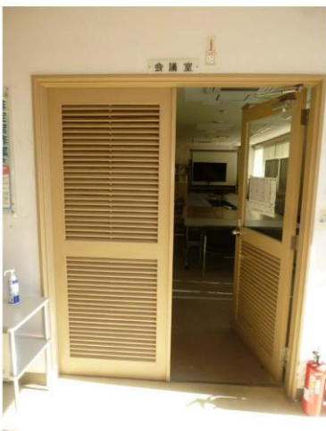
Na技開第3 会議室 (額付き両開扉)
