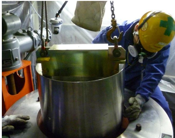
模擬案内管の取外し前
