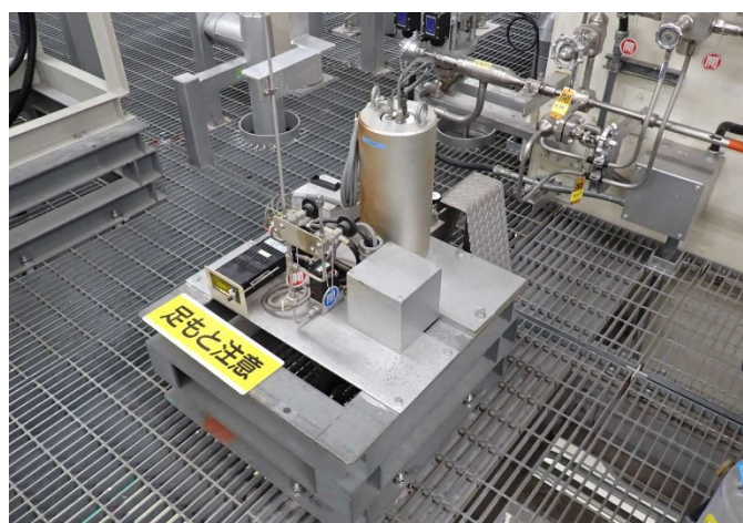
図 5 : 2 次ヘリウムサンプリング設備 \gamma 線検出器
