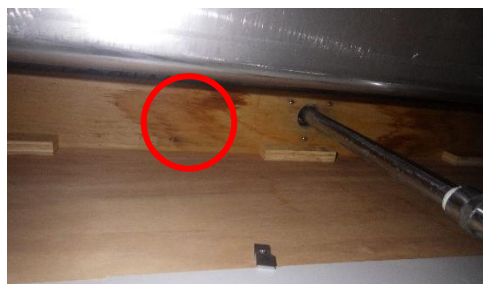
図 2. シンクの加工(配管接続口の作成)作業予定位置 左：穴あけ予定位置（シンク正面）、右：々（シンク下部）
